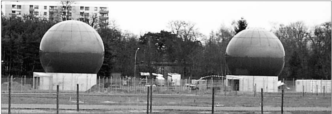
Die Satelliten-Kugeln auf dem ehemaligen August-Euler-Flugplatz werden in der Fachsprache als „Radome“ bezeichnet. Der Geheimdienstexperte Erich Schmidt-Eenboom sagte bei seinem Vortrag am Dienstagabend im Bürgerhaus St. Stephan, dass dies noch längst nicht der endgültige Ausbau der Anlage sei.
